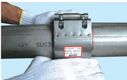
もう一方のパイプを配置し継手をマーキング位置に合わせます。
