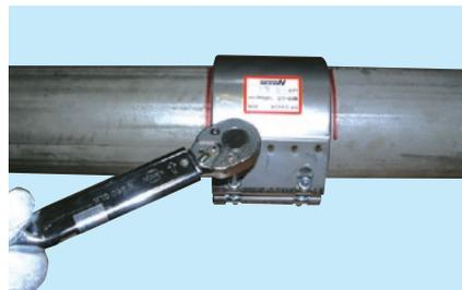
ボルトは片締めにならないように交互に締め上げて設定トルク値まで締付けます。
