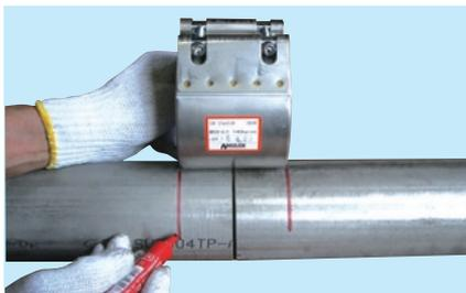
管端面にパイプ差込深さのマーキングをします。
